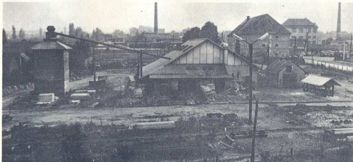
Pila a špýchar před demolicí.
