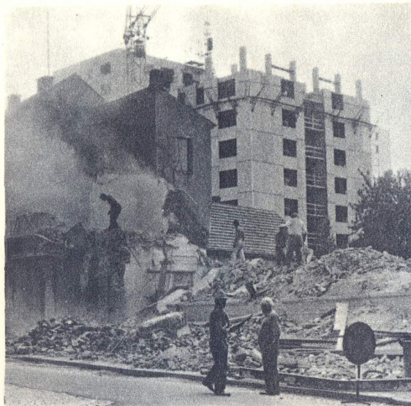
Demolice a nová výstavba – vzájemné soupeření.
