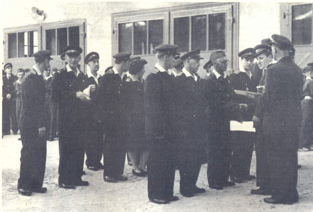
Otevření kult. míst. v I. patře zbrojnice, odměňování zaslouž. brigádníků v červenci 1971.
