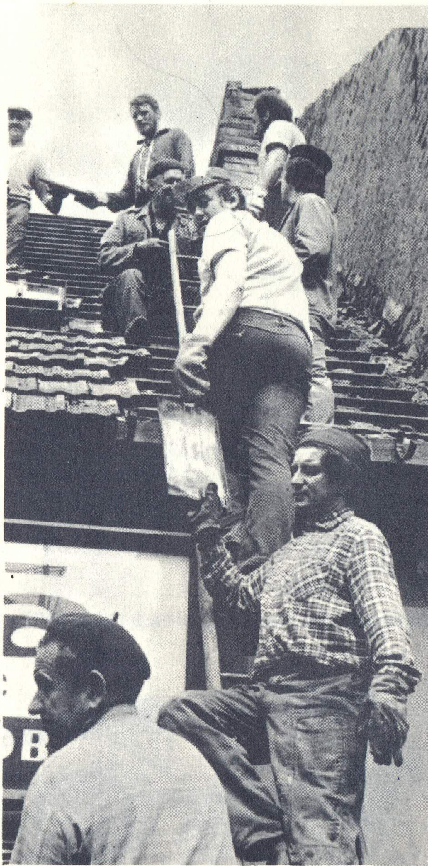
Demolice domů ve Fučíkově ulici.
