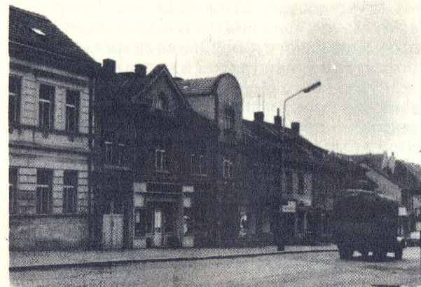
Část Komenského ulice před demolicí.
