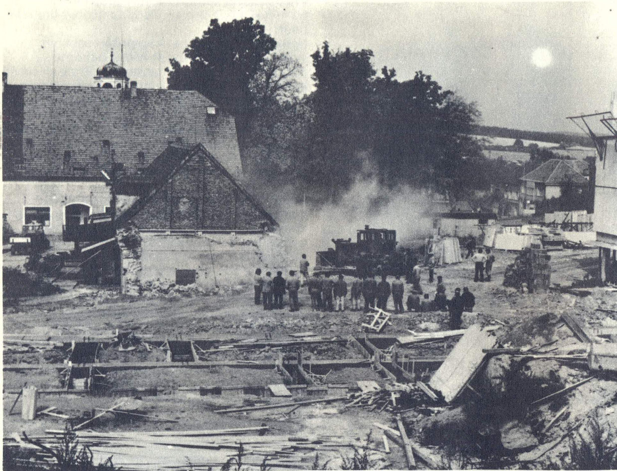
Nová výstavba pokračovala ihned za demolicemi – objekt OPP u zbrojnice.
